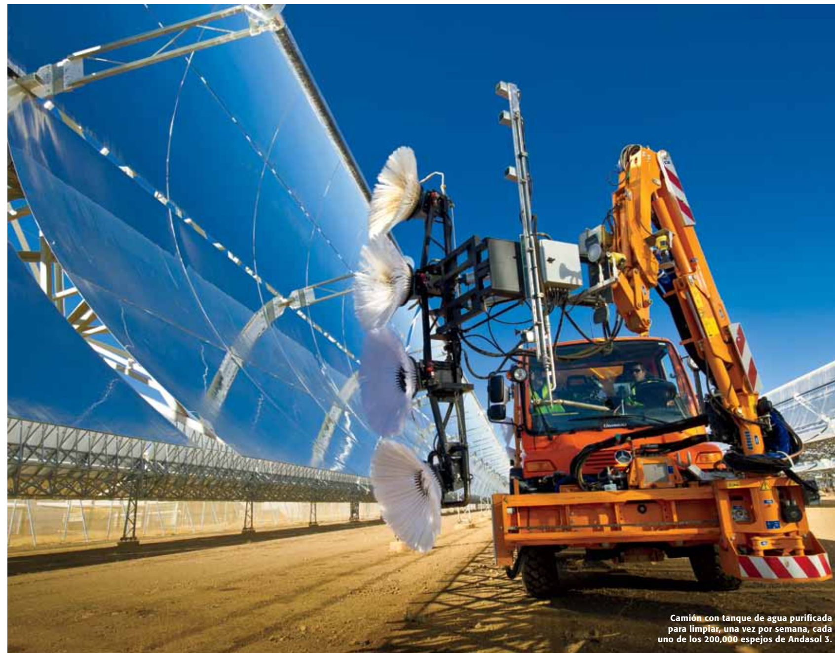
Trabajo de verificación de la reflexividad de los espejos de la central Gemasolar.
